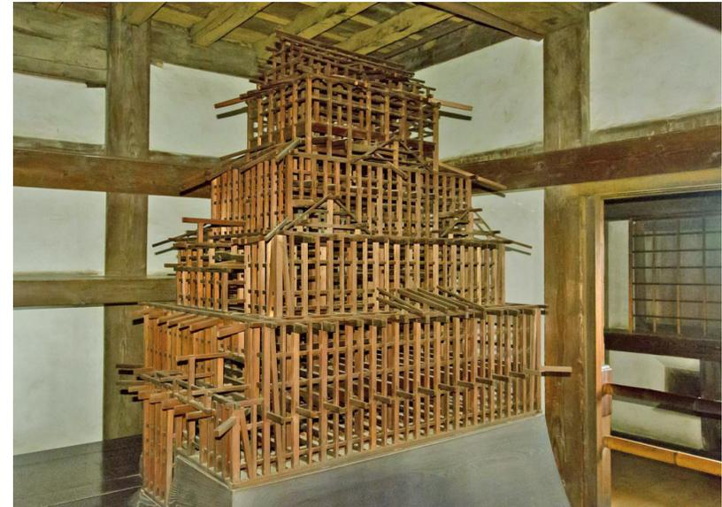
写真 2 姫路城の軸組構造模型 (1/20)
