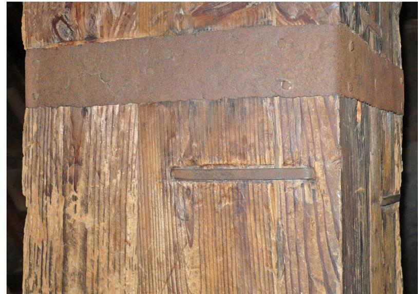
写真 4 天守柱材詳細 ( 細い木材を束ねている )
