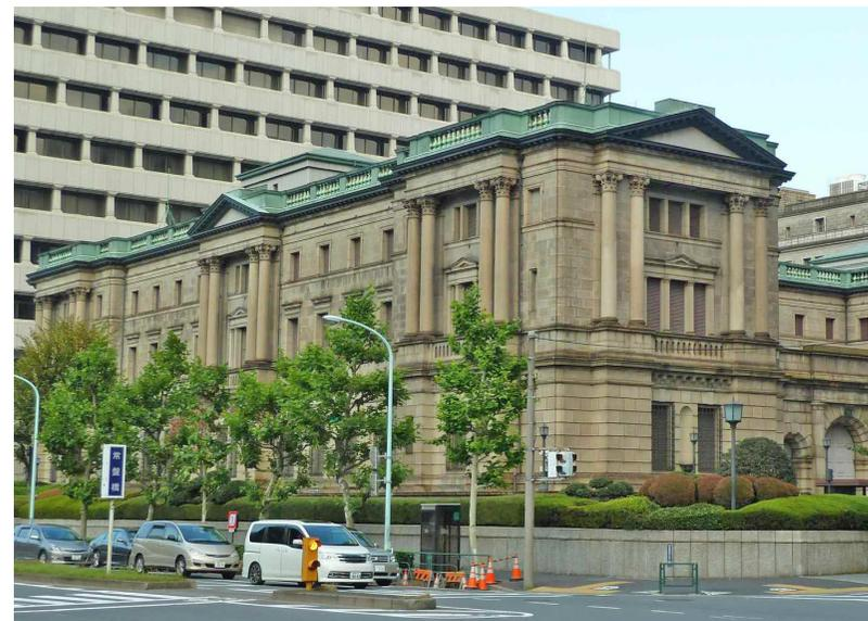
写真 2 外装 1 階に花崗岩 2 階と 3 階に安山岩
