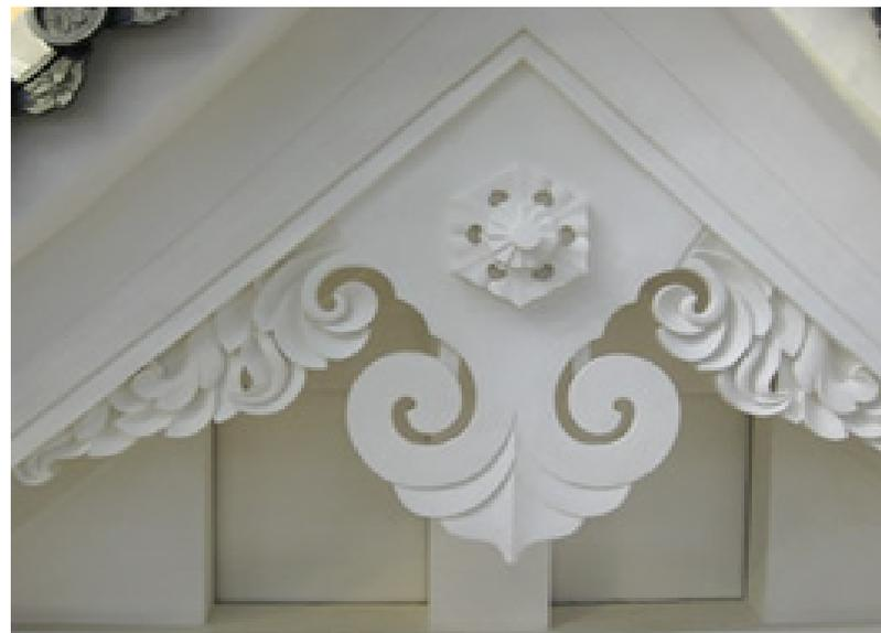
写真4 平成修理・完成した破風懸魚漆喰塗
