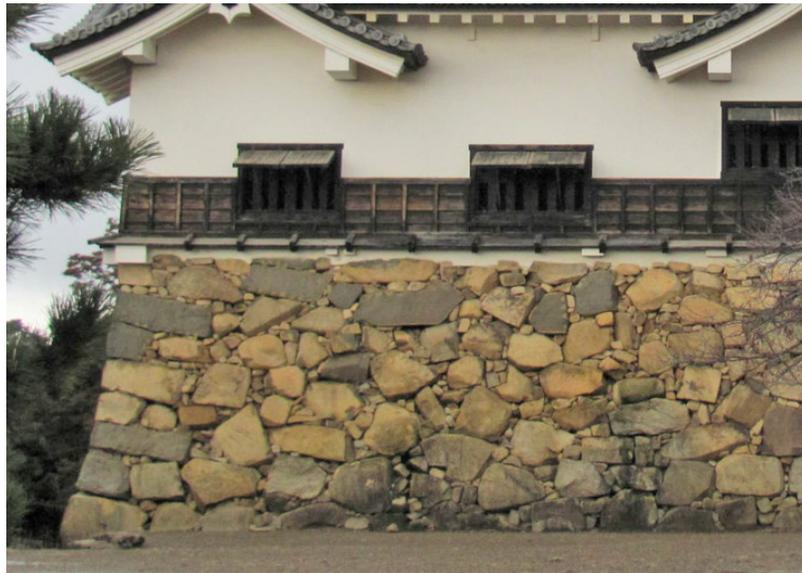
写真3 牛蒡積み（奥行きのある石を使用）の石垣
