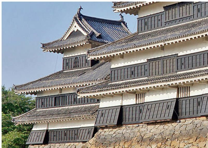
写真3 黒漆塗下見板と初重の石落し
