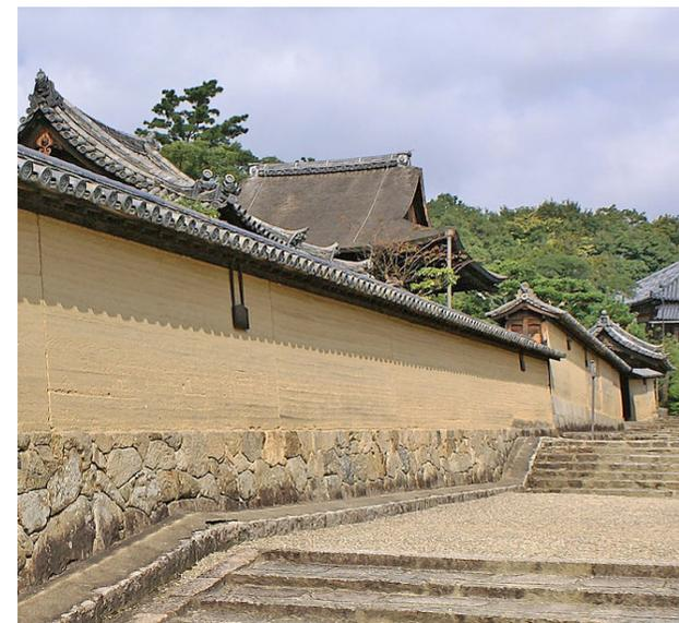
写真5 法隆寺の築地堀 (版築工法)
