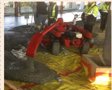
遠隔操作式コンクリート分配機
